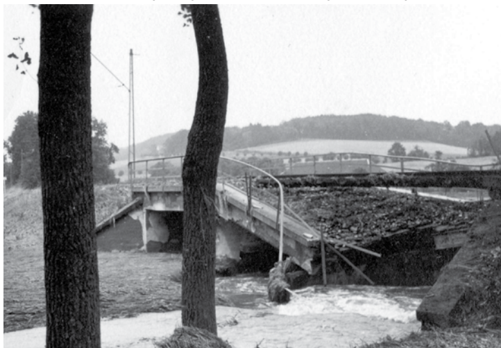
Extertalbahnbrücke in Vallentrup
