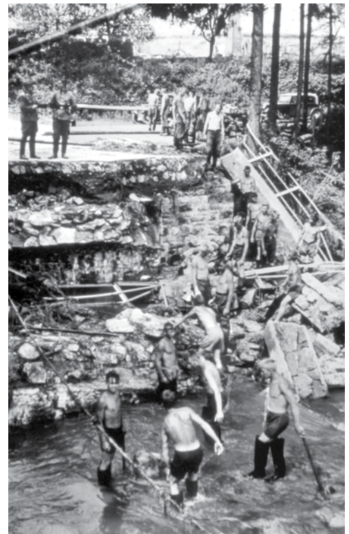
Aufräumarbeiten in Fütig (Reichsarbeitsdienst)
