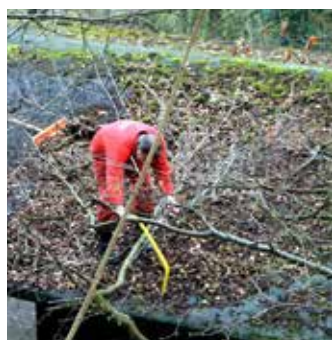
Auf's Dach gestiegen: Friedel Frevert säubert die Hütte.
