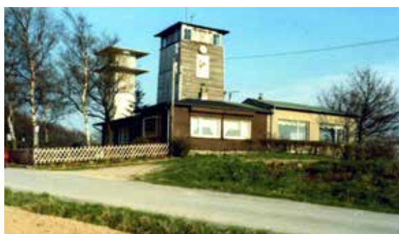
Das Turmcafé Ende der 1970er Jahre, noch mit beiden Türmen. Der alte wurde 1981 wegen Bauqualität abgerissen.
