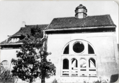
In der „Reichspogromnacht“ am 9./10. November 1938 wurde die Synagoge an der Südstraße völlig zerstört.
