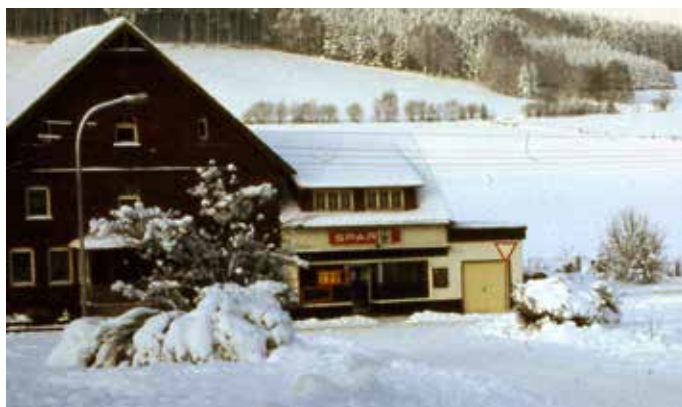
Im Jahre 2008 wurde das Elternhaus verkauft und einige Jahre später der Laden geschlossen. Inzwischen ist das Haus ganz und das Geschäft teilweise abgerissen worden.
