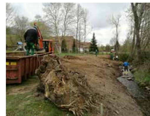
Mitarbeiter von „Wasser im Fluss“ beim Umgestalten des Uferbereichs.
