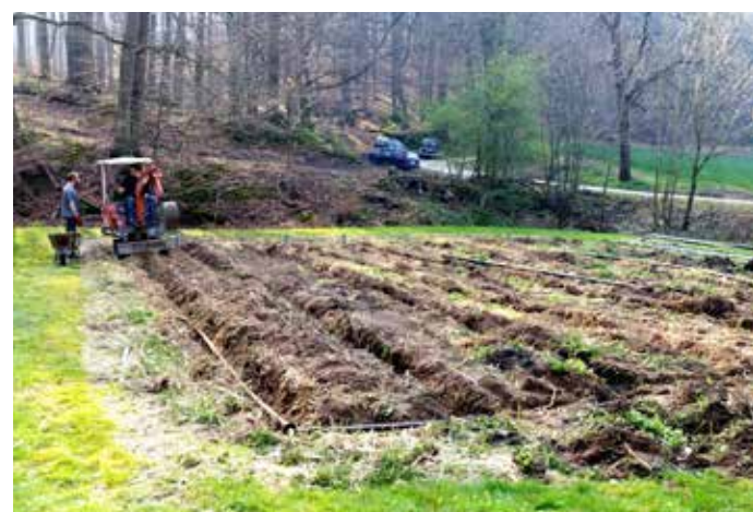
Akteure beim Rohre-Spülen im Klärbeet im Unterdorf.
